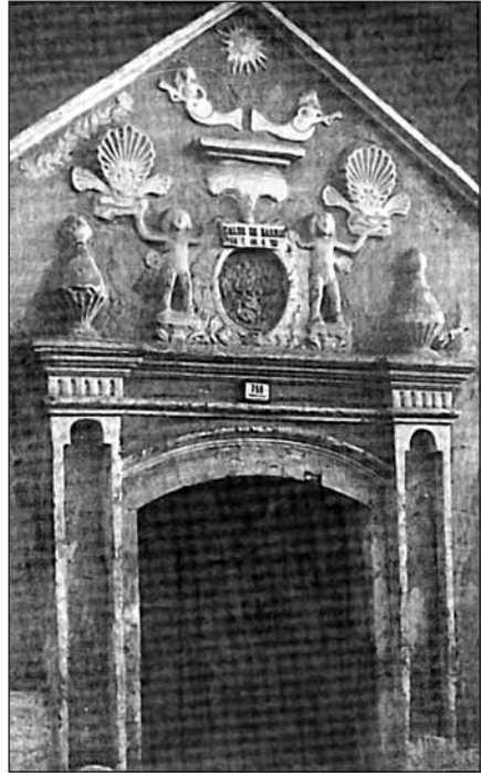
Casa de la calle Nogales 1755. Potosí
